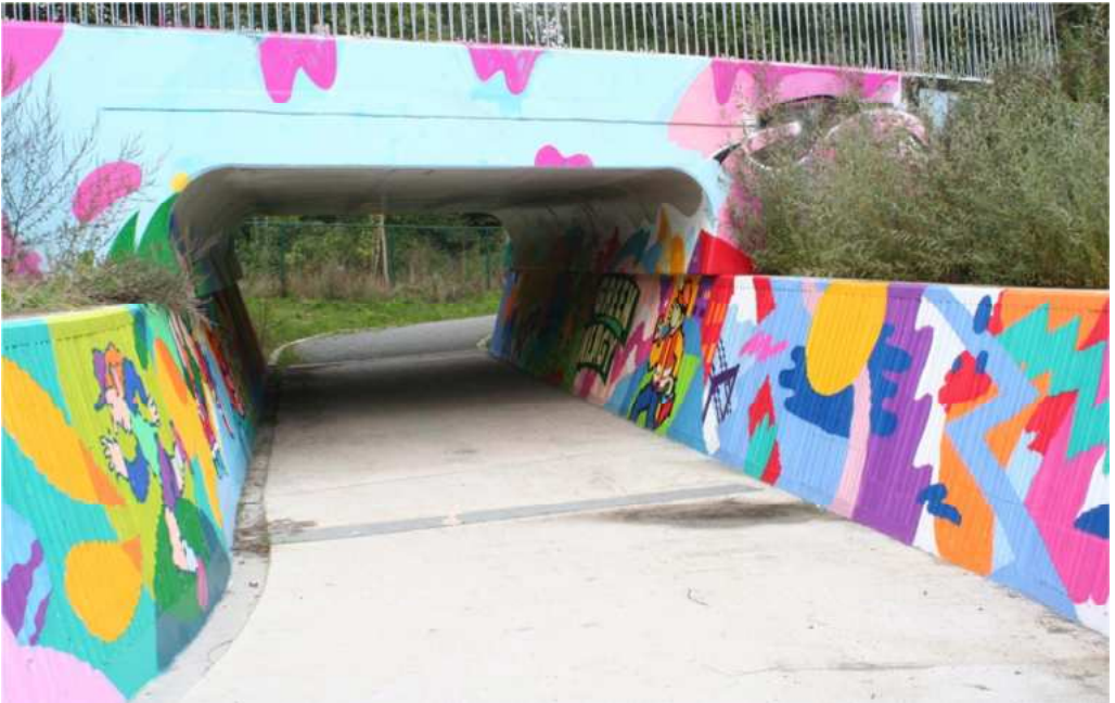
Tunnel piétonnier et cycliste reliant le marais de Ganshoren à celui de Jette.
